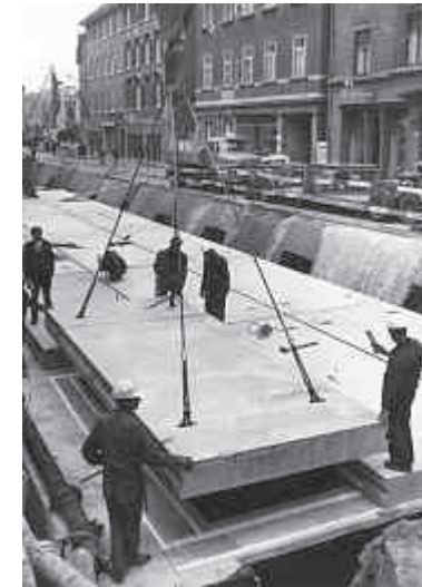
Mitte und rechts | Großbaustelle Hauptstätter Straße, Mitte 1968: Die Bohrpfahlwand ist fertiggestellt und das Pfahlkopfbankett wird vorbereitet, auf welchem die Fertigteile für die Deckelbauweise der Haltestelle Österreichischer Platz aufgelegt werden; diese Bauweise beschleunigte den Ablauf im Interesse der Anlieger.
