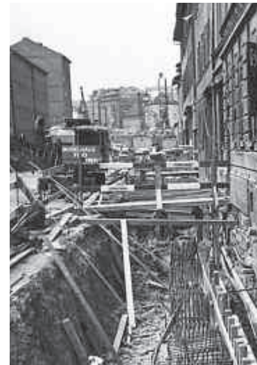
Links | Die Baugrube für die Haltestelle Neckartor, April 1970, Blick gegen Süden. Die Konturen des künftigen Bahnsteigbereiches sind hinter dem Lkw bereits erkennbar. Auch hier musste der laufende Straßenbahnverkehr in dieser Zeit provisorisch auf einer steilen Strecke über den Kernerplatz geführt werden, durch die Landhaus- und Urbanstraße.
