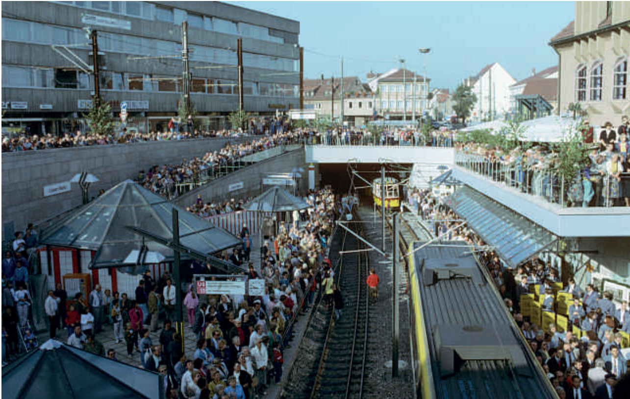
Links oben | 19. Juni 1984: Manfred Rommel würdigt den Durchschlag am Weinsteigtunnel (Liselotte-Tunnel). Am Geländeeinschnitt im Hintergrund erkennt man, dass der heutige kleine Zwischentunnel in offener Bauweise entstand.
