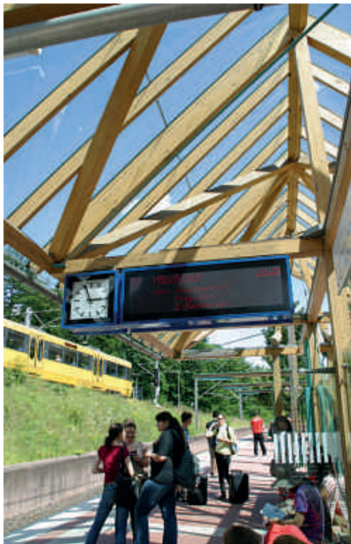
Holz im Wald: Die Rampenhaltestelle Ruhbank/ Fernsehturm (Architekt Frank und Partner) nimmt Bezug auf ihre Umgebung. Hier treffen sich die „schnelle“ Tunnellinie in die City, die Filderquerlinie und die noch immer teils straßenbahnähnliche Panoramalinie – schon daher ein „Muss“ für Touristen.
