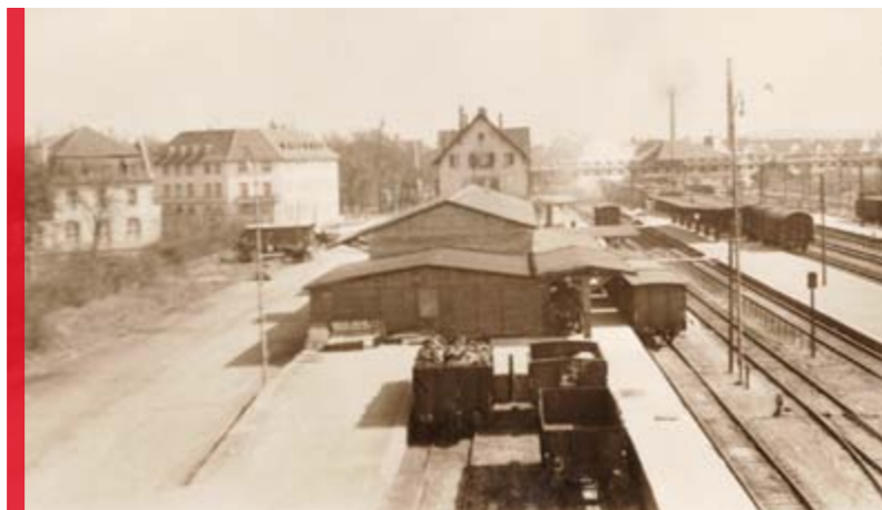
Bahnhof mit Güterbahnhof, um 1950
