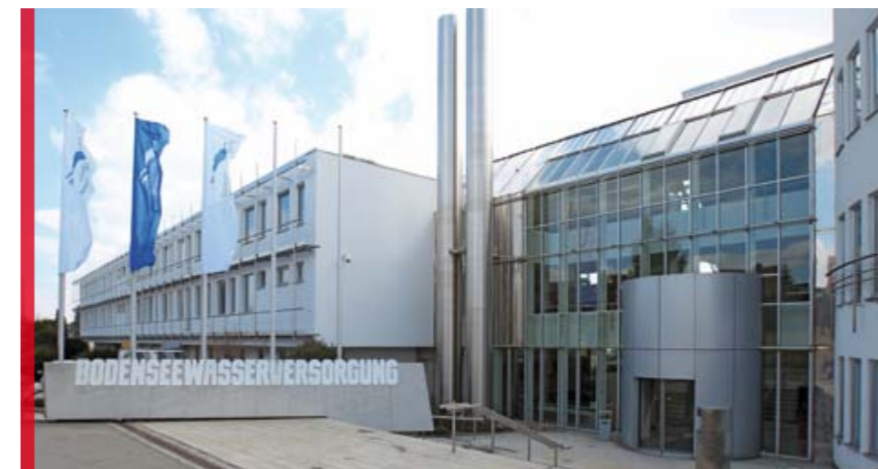
Verwaltungsgebäude der BWV
