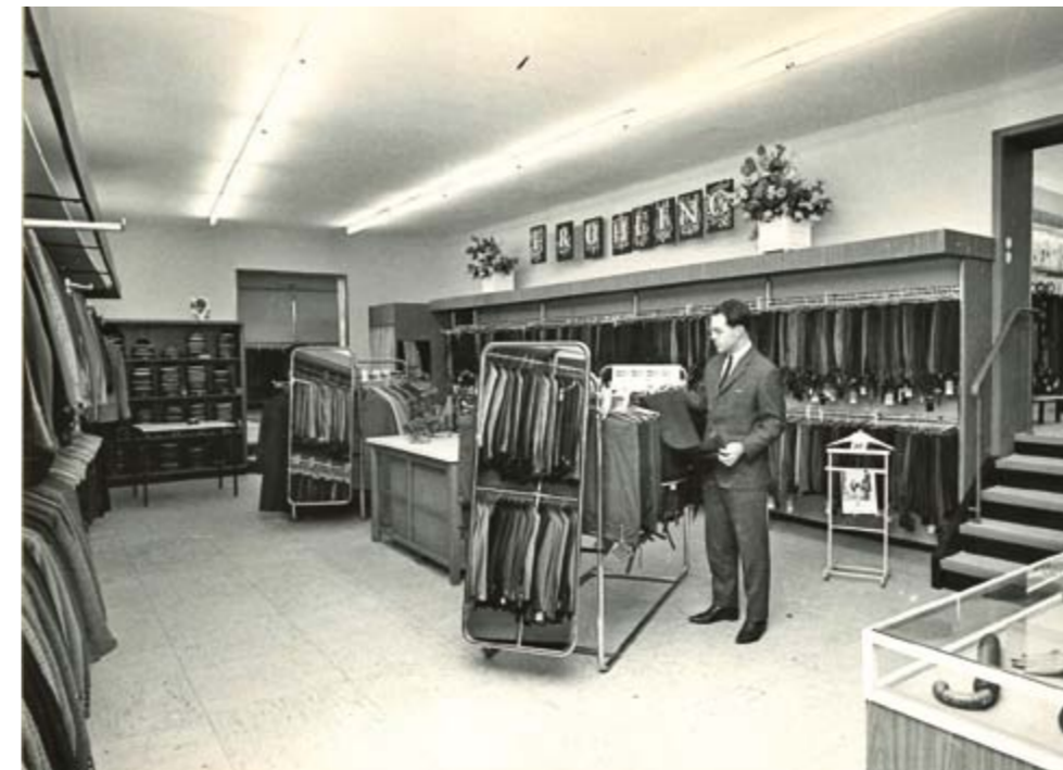
Herrenhaus nach dem Umbau im Frühjahr 1966
